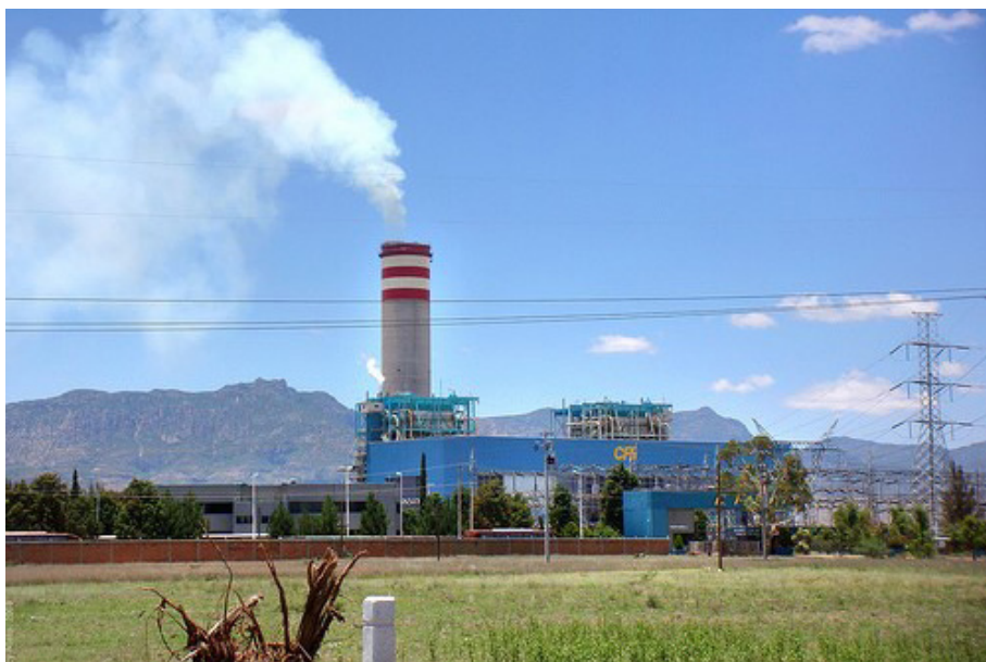
Figura 1. Central termoeléctrica Villa de Reyes
