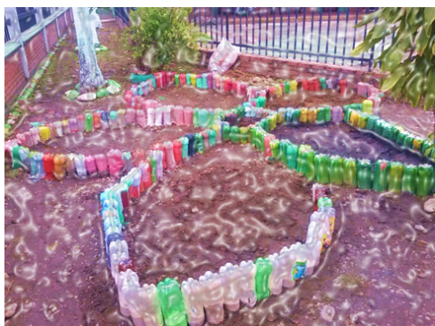
Cifuentes, C. (2016). En la imagen: Primera de la huerta Escolar recientemente construida [Fotografía]. Villavicencio-Meta.
