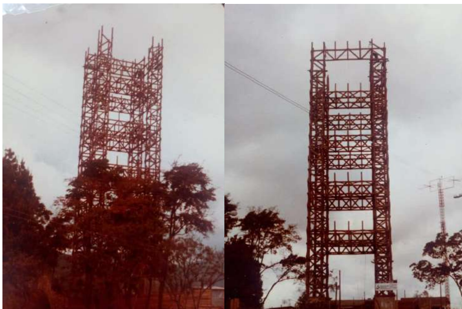
Figura 1 Montaje de la Torre del Cable (1983)
